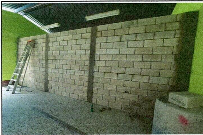
Foto 3: MEJORAMIENTO DE PAREDES
