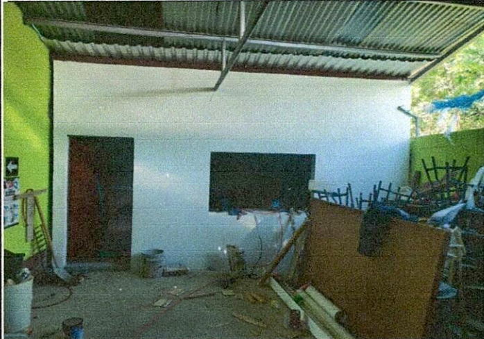
Foto1: MEJORAMIENTO DE ESTRUCTURA DE COCINA
