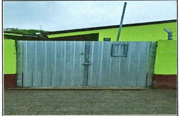
SUSTITUCIÓN DE PORTON
