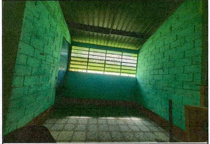
Foto 2: MEJORAMIENTO DE PAREDES
